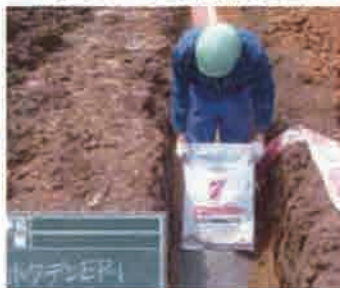
ホクデン EP-1 敷設 (粉状にて施工)
